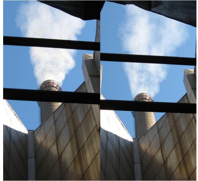
Слика 14. На левом делу слике приказан је изглед дима у конфигурацији 4 x 50Hz. На десној страни слике приказан је изглед дима у конфигурацији 2 x 50Hz + 2 x ВФ.
