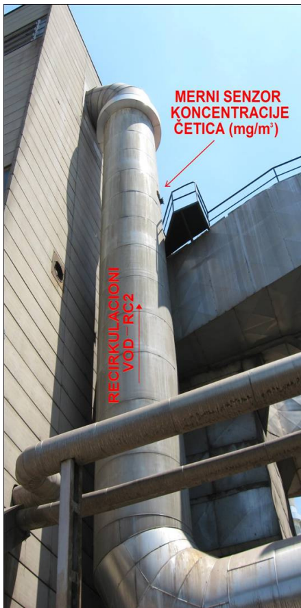
Слика 13. Место уградње трибоелектричног давача.
